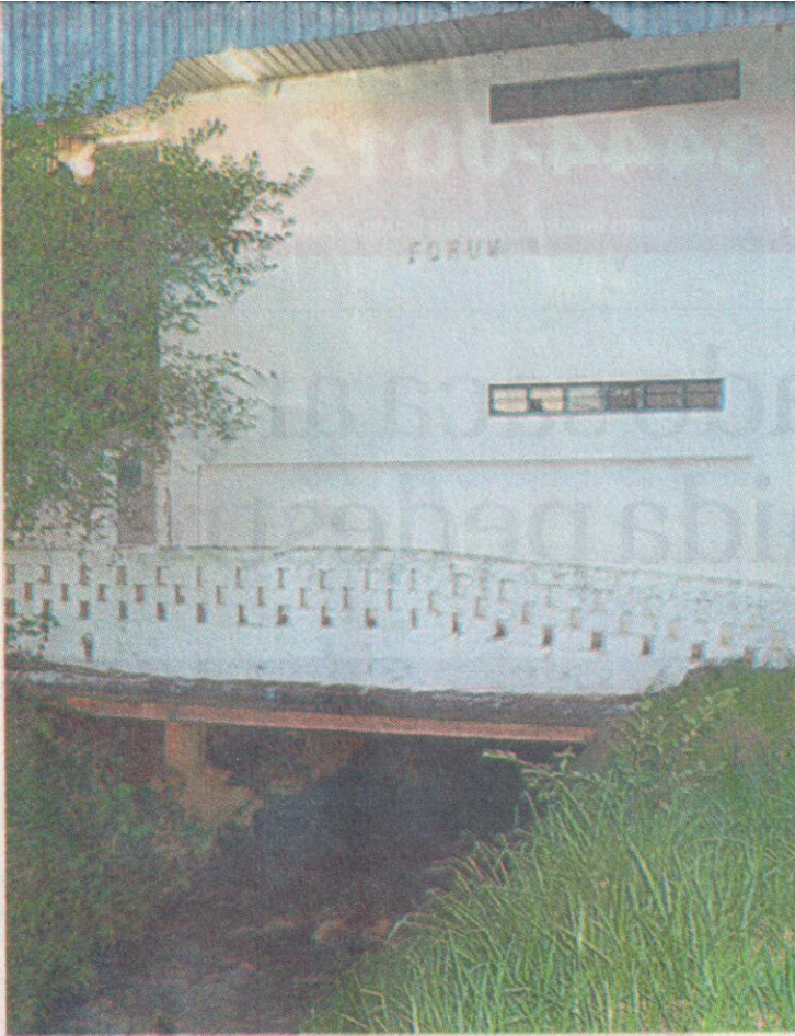
Em Monte Sião, fórum erguido sobre rio apresenta danos estruturais
