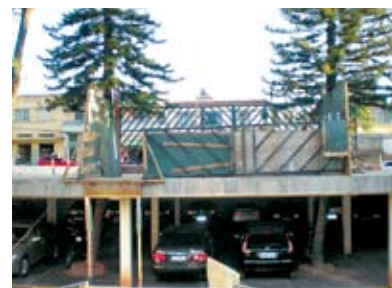
Faixa do Fórum ocupada por obras da prefeitura
